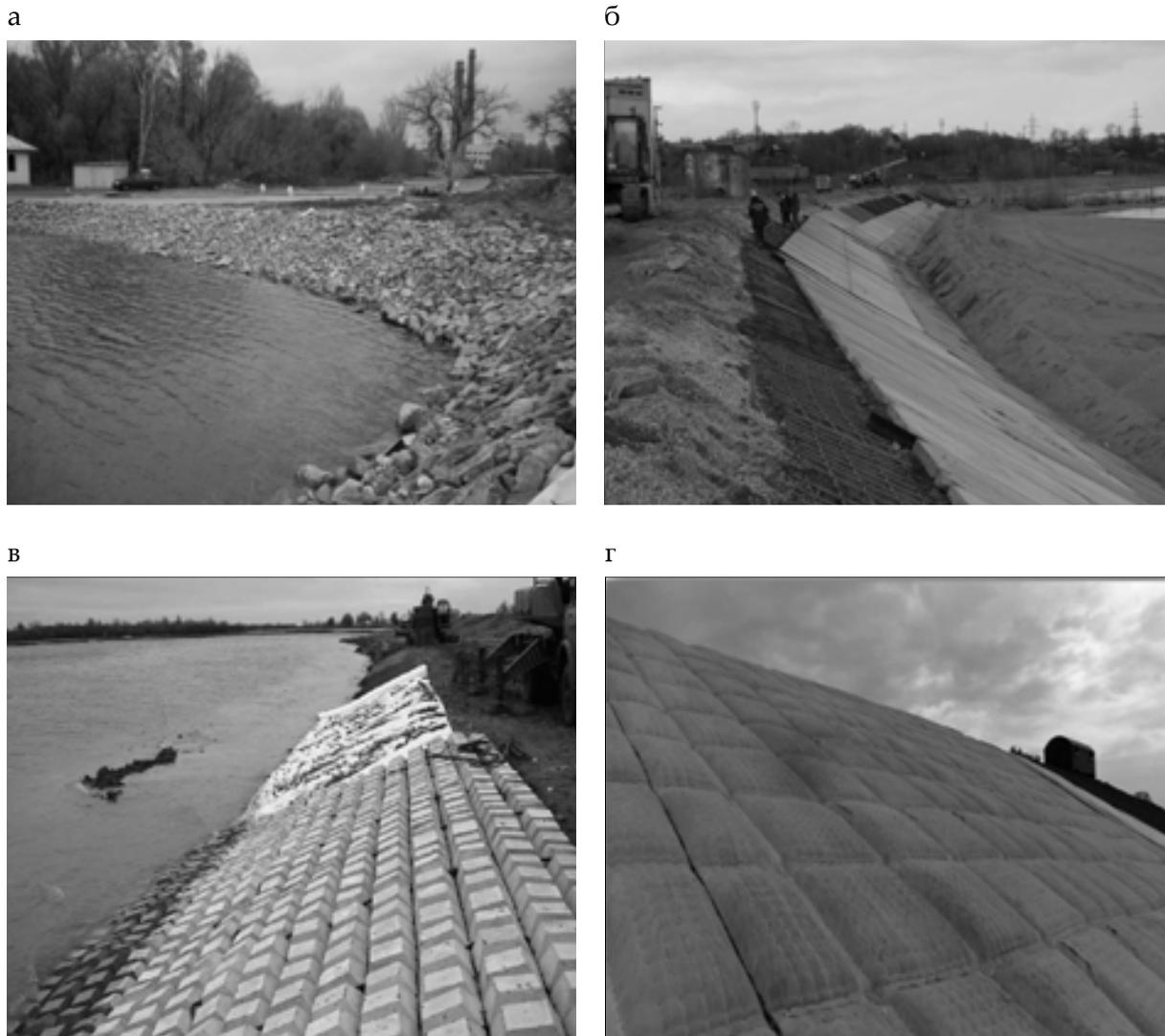
Рис. 1. Технические решения креплений береговых подтопляемых откосов:
