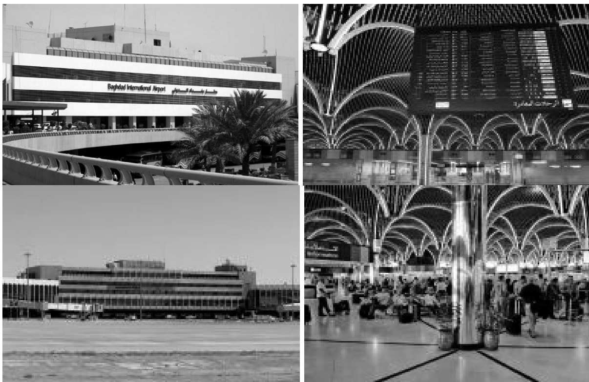
Рис. 3. Здание аэропорта в Багдаде [7]
