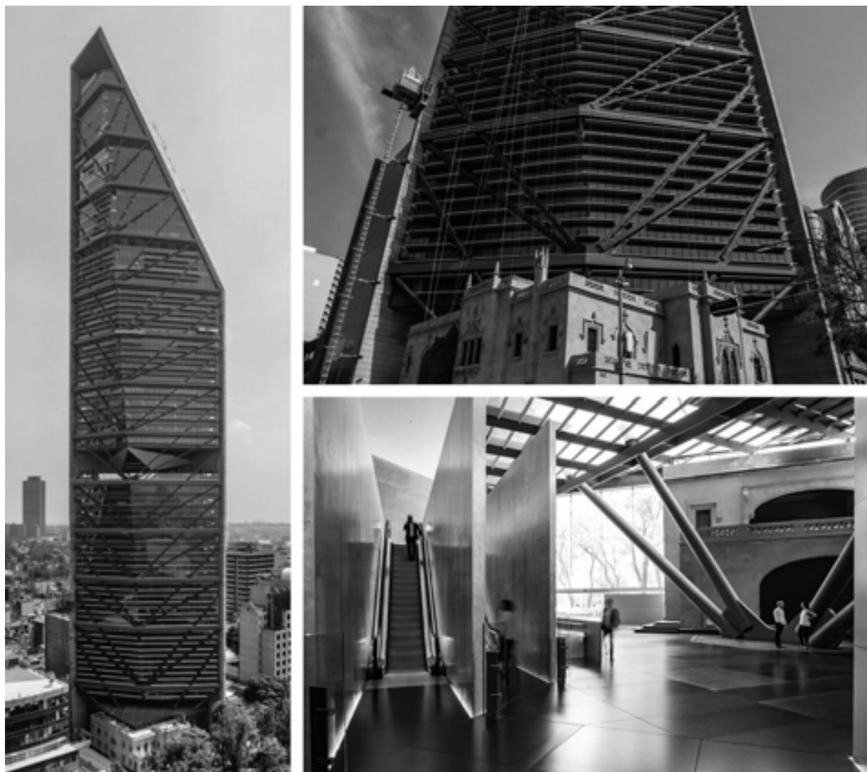
Рис. 2. «Torre Reforma», Мехико, 2016 г., 246 м [http://www.torrereforma.com/galeria.php?i=en]
