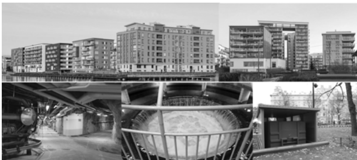
Рис. 2. Жилая застройка района «Hammarby Sjöstad» (Швеция)
