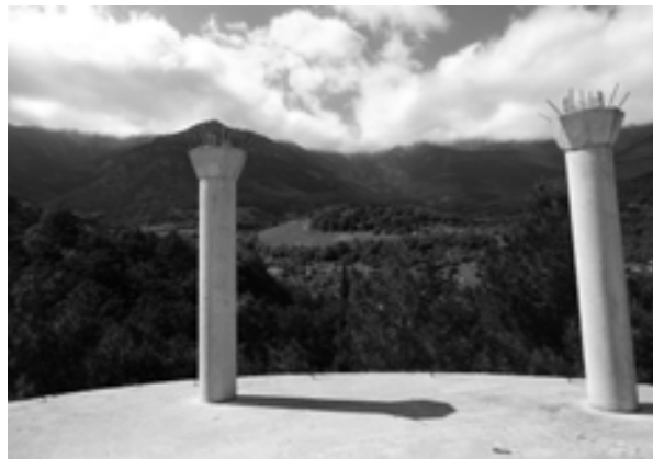
Рис. 3. Вид колонн 3-го этажа незавершенного строительством здания
