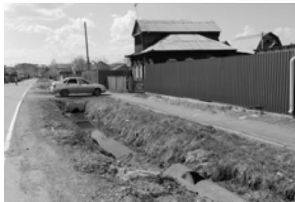
Рис. 3. Современное состояние системы водоотведения поверхностного стока района: а – ул. Самарцева (автодорога группы А); б – ул. Шахтеров (автодорога группы Б)
