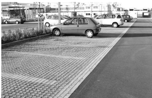
Рис. 1. Биопозитивное покрытие на автомобильной парковке
