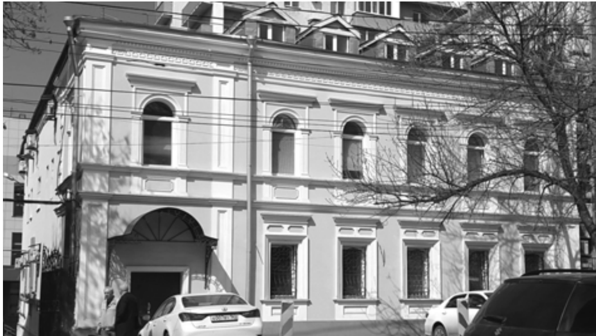
Рис. 7. Усадьба М.П. Чубакова (ансамбль): а – до реставрации. Фото 2014 г.; б – архивные фото 1993 г.; в – после реставрации. Фото 2017 г.
