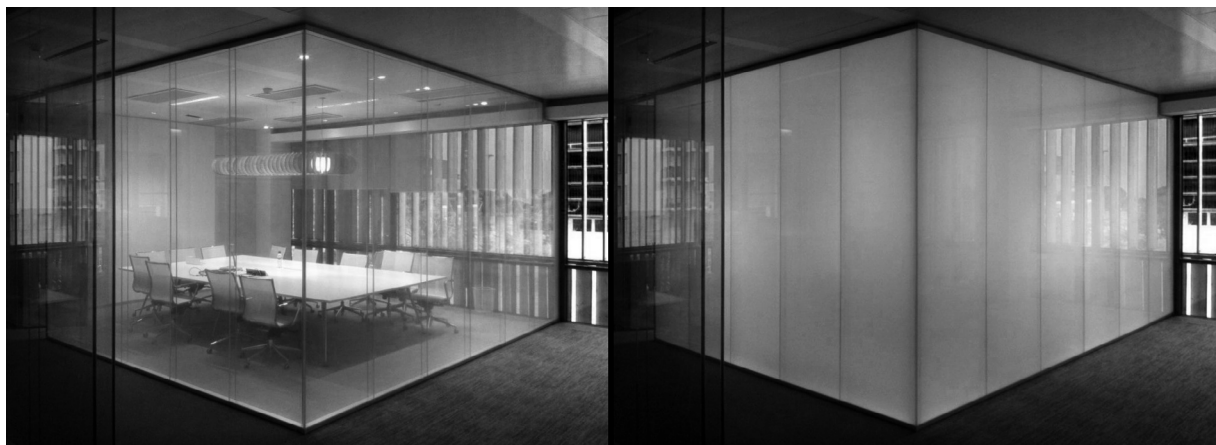
Рис. 2. Электрохромное смарт-стекло SmartGlass в офисе компании Microsoft в Лиссабоне, Португалия (слева при подаче электрического тока, справа в выключенном состоянии)
