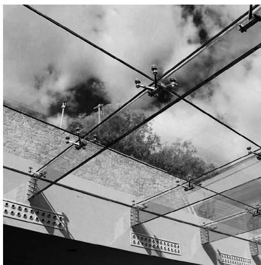
Рис. 1. Стеклянная балка производства GLASSCON GmbH
