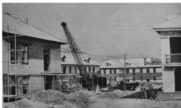
Рис. 11. Строительство новых домов в поселке ЗиС, 1948 г. [29]
