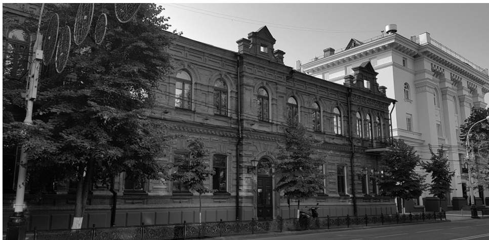
Рис. 1. Историческая застройка ул. Красной в Краснодаре. Южная сторона. На переднем плане памятник архитектуры федерального значения «Дом купца Никитина, конец XIX в.»
