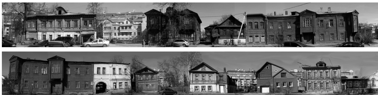
Рис. 1. Фрагменты деревянной застройки по улицам Славянской, Студеной. 2013 г.
