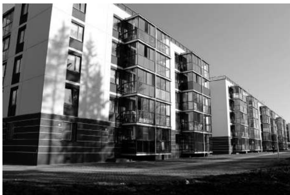
Рис. 2. Жилой дом из легкобетонных панелей
