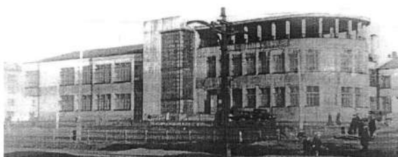
Фото 1. Вид на фабрику-кухню с севера. 1940-е гг. Из частной коллекции В.В. Семяникова
