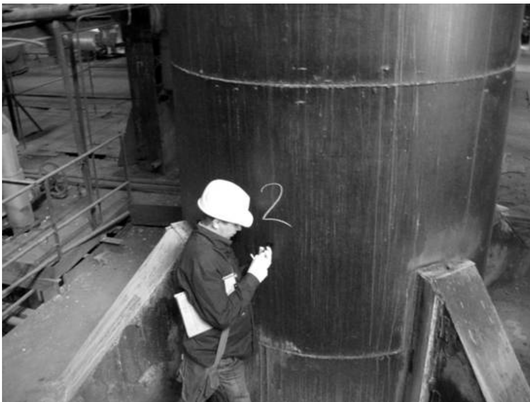
Рис. 1. Обследование дымовых труб: а – железобетонной, со светофорных площадок и ходовой лестницы; б – металлической (замер остаточной толщины металла ствола)
