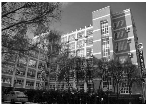
Ул. Красноармейская, д. 17. Дом Связи. Александр Полев (1930-1938)
