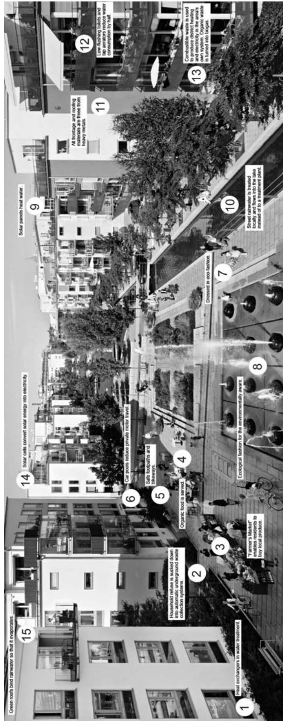
Рис. 4. Швеция, Стокгольм. Фрагмент района Hammarby Sjöstad. На рисунке шифрами показаны следующие обозначения: 1 - водяной теплообменник в системе очистки воды; 2 - домашние отходы утилизируются вакуумными приемниками, пакеты для мусора сделаны из кукурузного крахмала, система находится под видеонаблюдением и контролируется; 3 - мини-рынок для фермеров позволяет жителям купить местный продукт; 4 - место потребления органических продуктов; 5 - безопасные пешеходные пути и велосипедные дорожки; 6 - Carpool – безвозмездный провоз попутчиков при ежедневных поездках; 7 - экологичная одежда; 8 - эко-дизайн; 9 - солнечные панели, нагревающие воду; 10 - дождевую воду очищают и направляют в озеро; 11 - фасад и материалы кровли не содержат примеси тяжелых металлов; 12 - на краях установлены аэростаты, уменьшающие расход воды; 13 - органические отходы перерабатываются в биогаз; 14 - солнечная энергия перерабатывается в электричество; 15 - «зеленая» кровля
