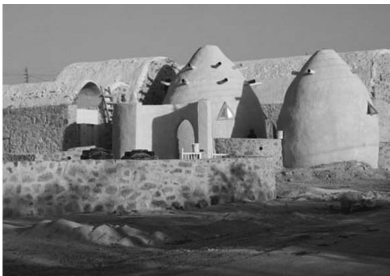
Внешний вид зданий, построенных по технологии «Суперсаман»
