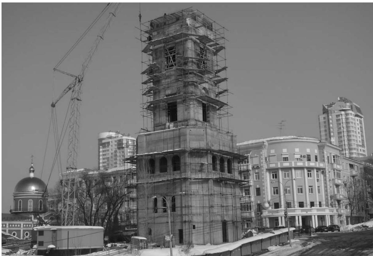
Рис 1. Общий вид строящейся колокольни
