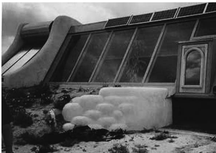
Пример дома, построенного по технологии Earthship
