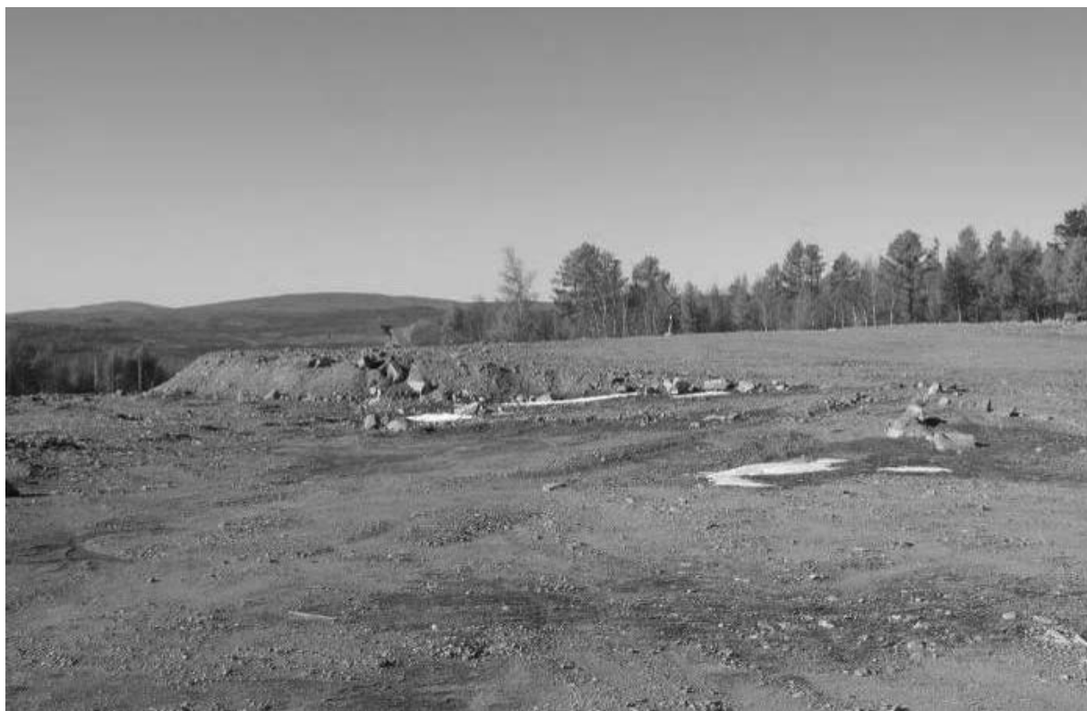
Рис. 2. Общий вид площадки перед началом строительства
