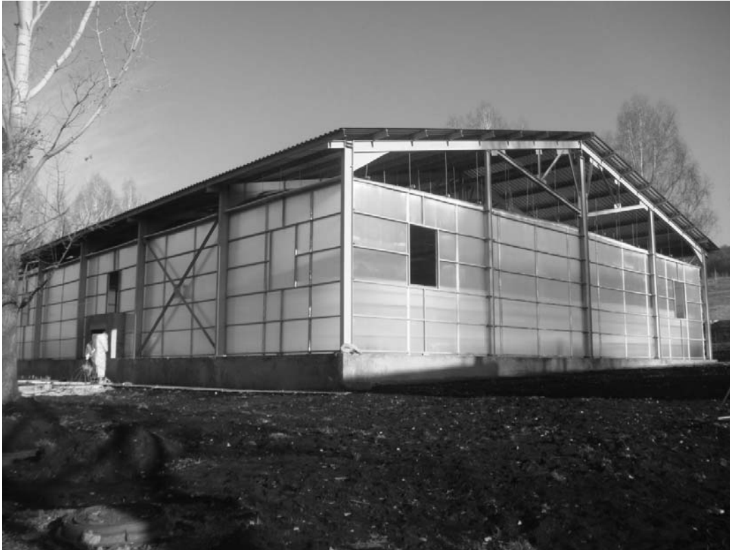
Рис. 3. Общий вид реконструируемого здания в момент окончания работ
