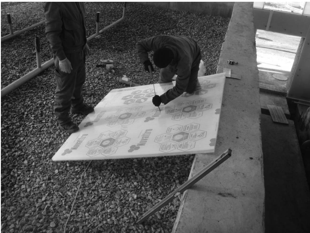
Рис. 4. Монтаж внутренней обшивки здания из листов многослойного поликарбоната
