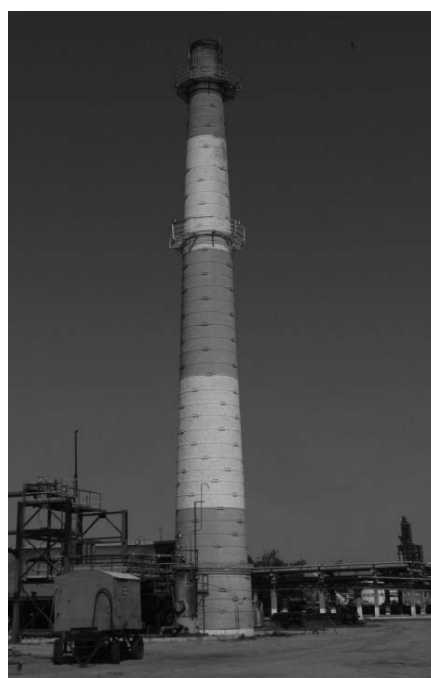
Рис. 1. Общий вид дымовой трубы
