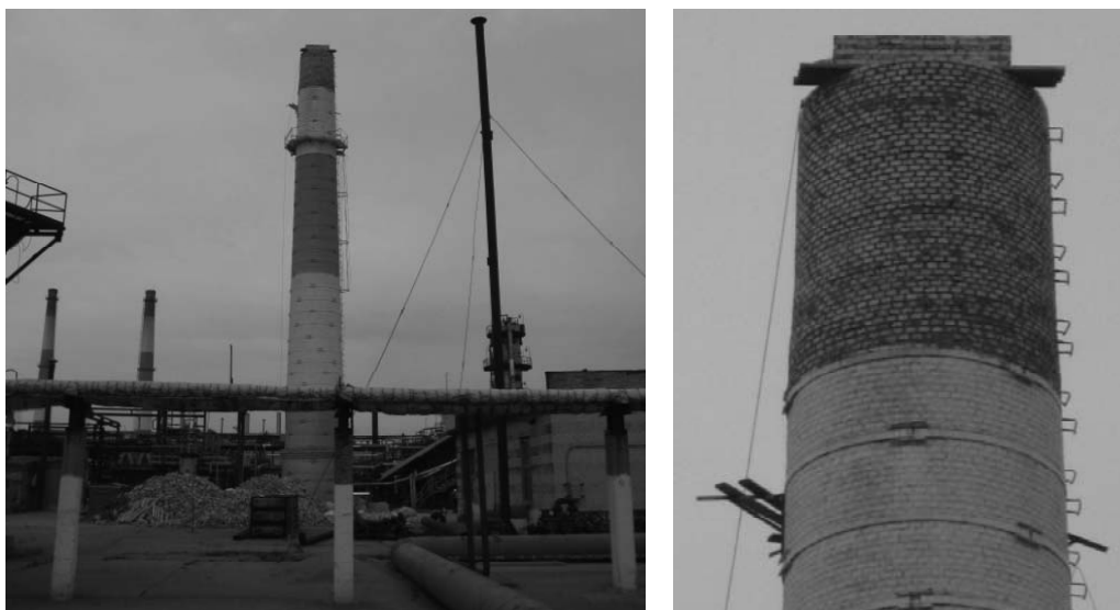
Рис. 4. Перекладка оголовка трубы
