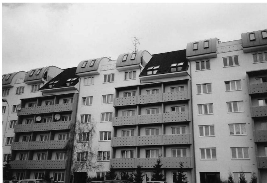
Рис. 3. Реконструкция «хрущёвки» в современном исполнении
