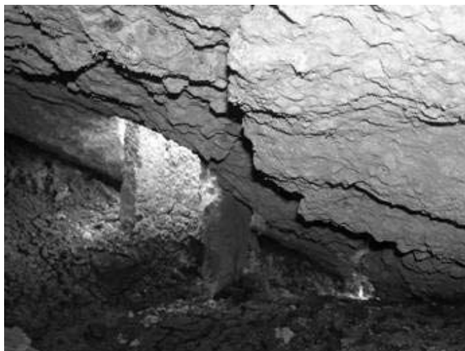
Рис. 9. Участок промыва грунта
