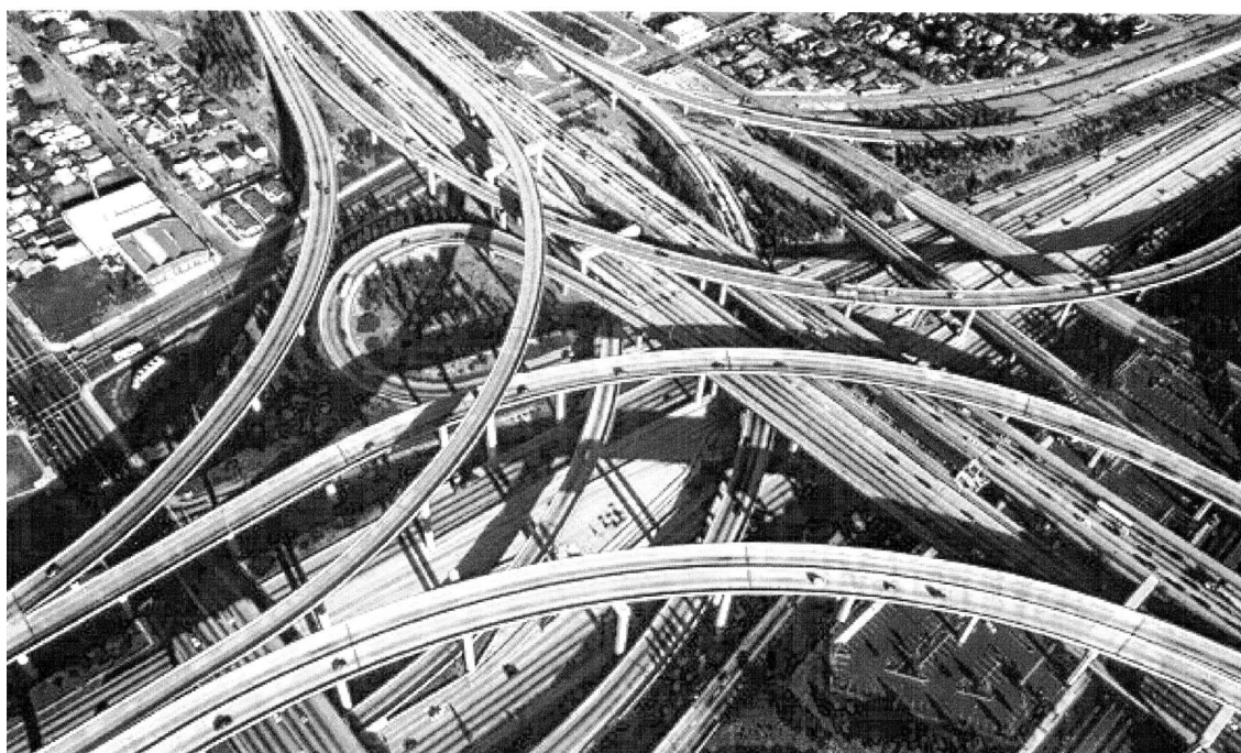
Рис. 1. Транспортная развязка в Лос-Анджелесе, имеющая пять уровней дорог
