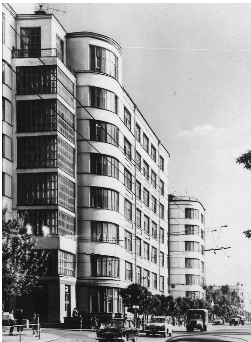
Рис. 2. Дом промышленности, ул. Куйбышева, инженер В.К. Сухов, архитектор В. Клочков, фотография 1969 г.
