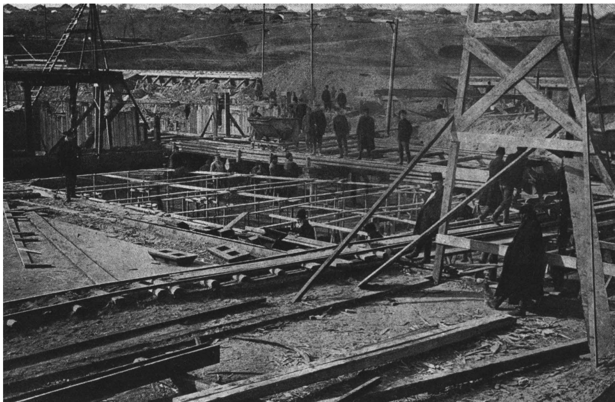
Рис. 3. Работы по бетонированию верхней головы шлюза гидроузла № 6
