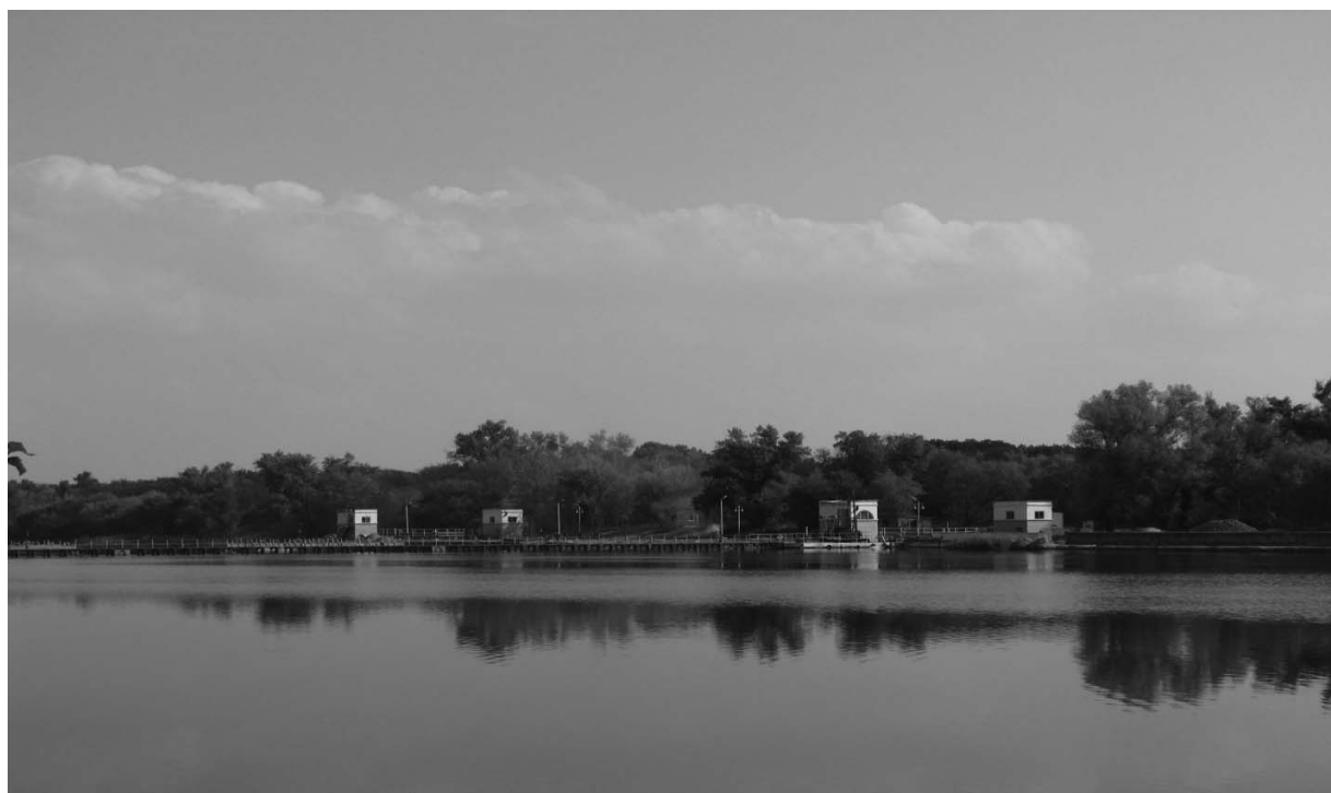
Рис. 2. Гидроузел №5 Северско-Донецкой шлюзованной системы
