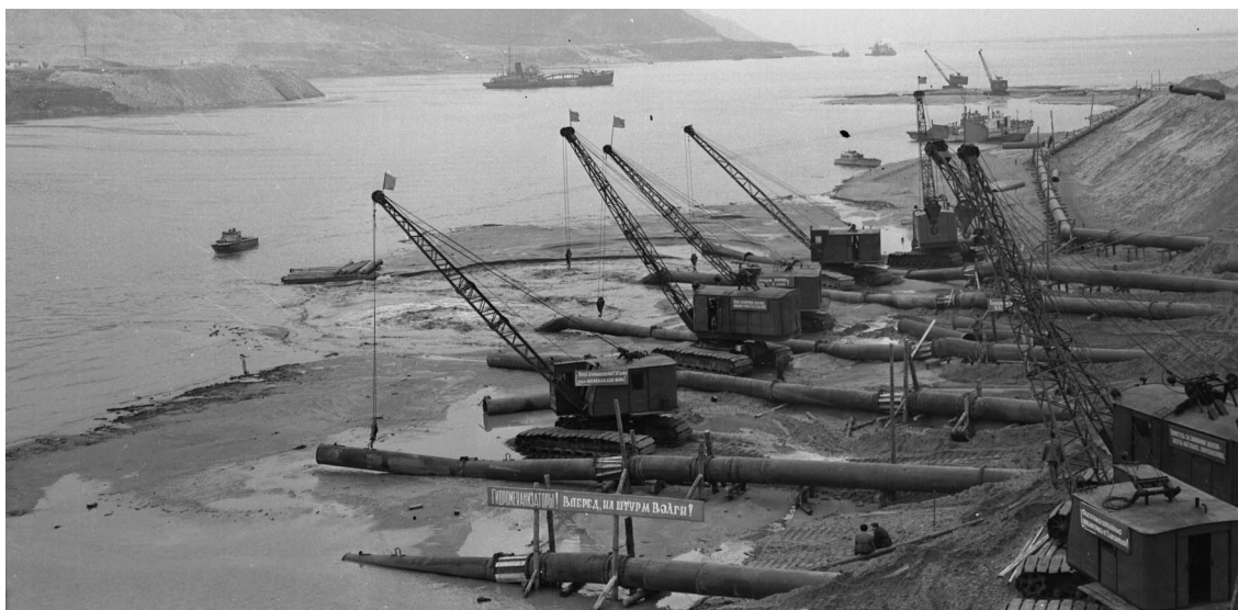
Рис. 3. Возведение грунтовой плотины (фото В.Е. Кондратьева)
