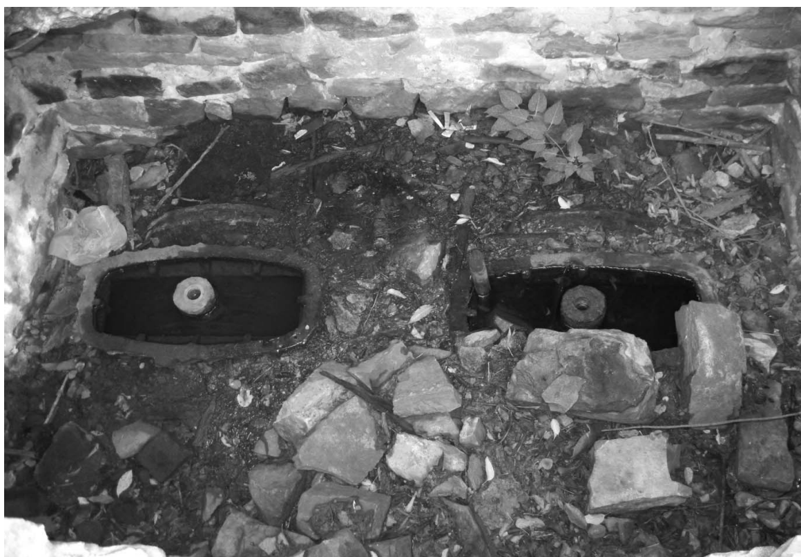
Рис. 4. Смотровой колодец водоспуска
