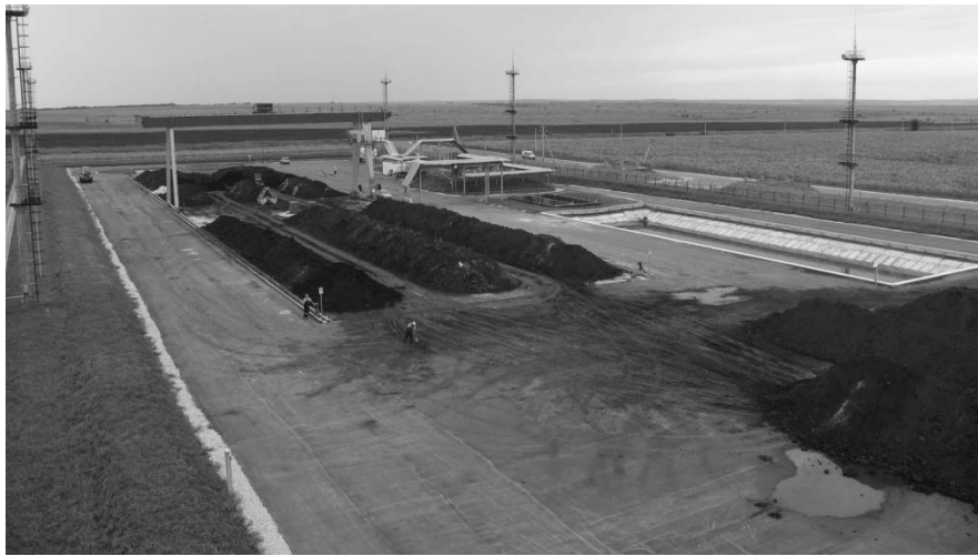
Рис. 1. Общий вид комплекса обработки нефтешламов ОАО «Самаранефтегаз»
