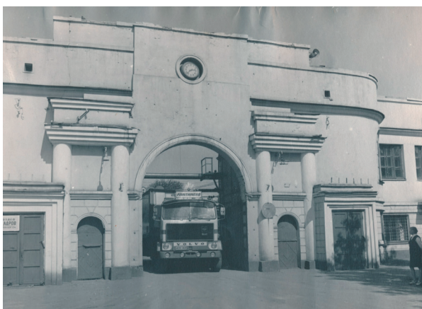
Рис. 5. Здание проходной завода СК-1, пр. Октября, 78Г, г. Ярославль (середина 1930-х)
