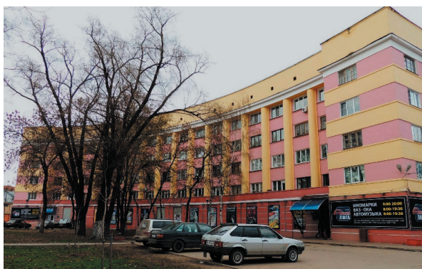
Рис. 3. 130-квартирный жилой дом, пр. Октября, 34/21, г. Ярославль (1934–1937)
