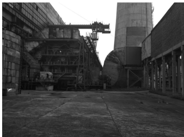
Рис. 3. Площадка для установки дымососа
