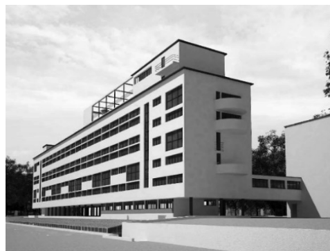
Рис. 8. Дом-коммуна Наркомфина на Новинском бульваре (Москва, Россия, арх. М. Гинзбург, 1928–1930 гг.)
