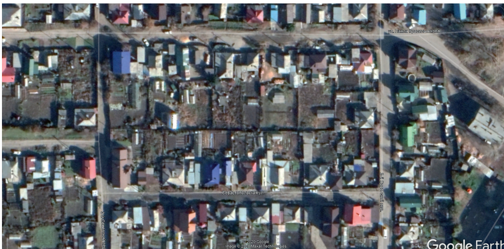
Рис. 6. Односемейная одноэтажная застройка с индивидуальными земельными участками в поселке Порт Артур, район Новоленино, первая половина XX в. Fig. 6. Single-family one-story development with individual land plots in the village of Port Arthur, Novolenino district, the first half of the 20th century
