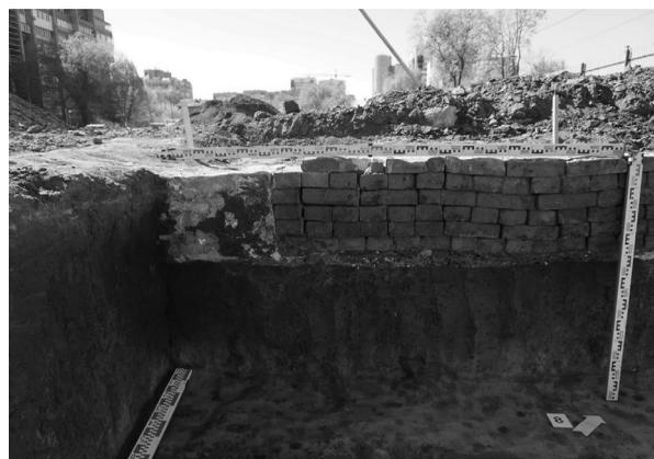
Рис. 8. Подземная конструкция из кирпича без раствора
