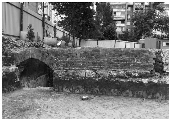
Рис. 5. Общий вид подземной части здания из глыб известняка с кирпичной стеной
