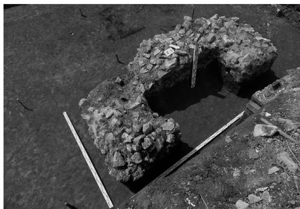
Рис. 7. Фундамент из глыб известняка с небольшой примесью битого кирпича (второй тип)
