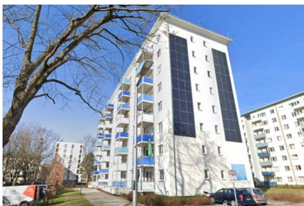
Рис. 5. Солнечные батареи на кровле Fig. 5. Solar panels on the roof
