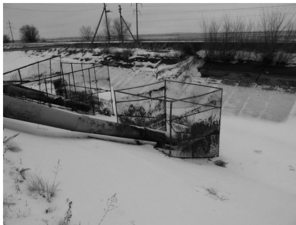
Рис. 5. Водозаборное сооружение насосной станции НС-42п до реконструкции
