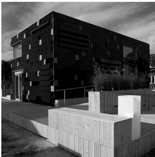
Рис. 1. Здание с навесным фасадом из фотоэлектрических батарей [7]
