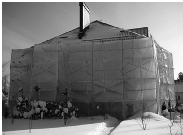
Рис. 4. Устройство «тепляка» на фасаде здания в зимний период
