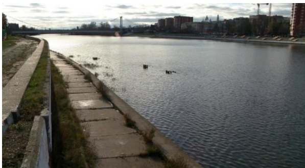
Рис. 6. Набережная Суры до реконструкции
