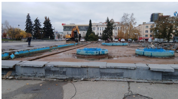
Рис. 10. Улица Московская до реконструкции
