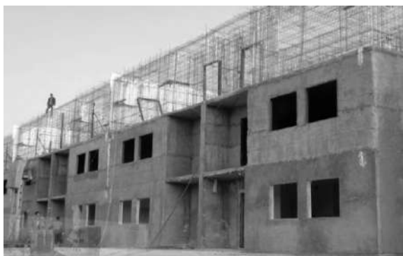
железобетон, монолитная, стеновая
