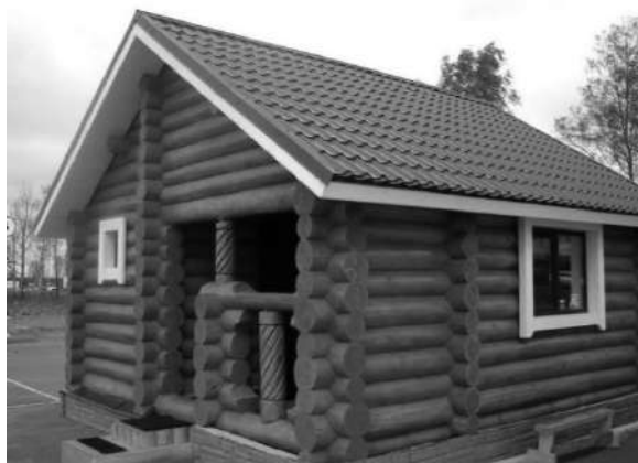
малоэтажный объект с применением традиционной (стеновой) архитектурной системы
