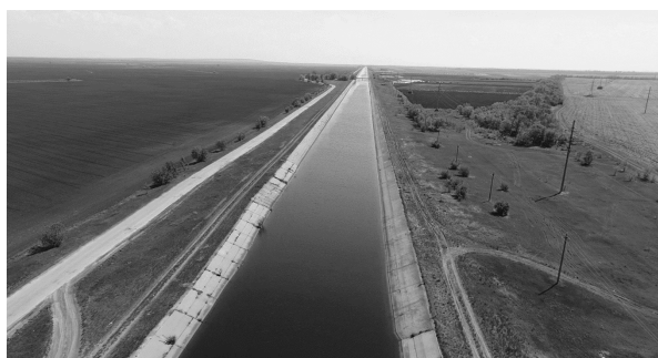
Рис. 1. Магистральный канал Комсомольской оросительной системы (Саратовская область) Fig. 1. Main channel of the Komsomol irrigation system (Saratov region)
