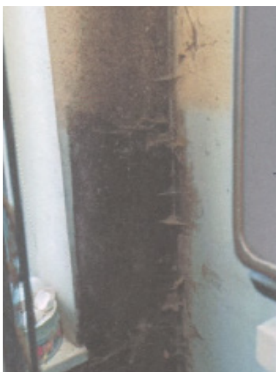
Рис. 4. Угловое сопряжение стен квартиры в Красноглинском районе (на фасаде расположен технологический шов) Fig. 4. Corner joining of the walls of an apartment in Krasnoglinsky district (process weld is located on the facade)
