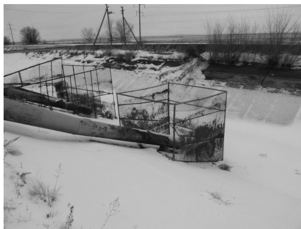
Рис. 5. Водозаборное сооружение насосной станции НС-42п до реконструкции
