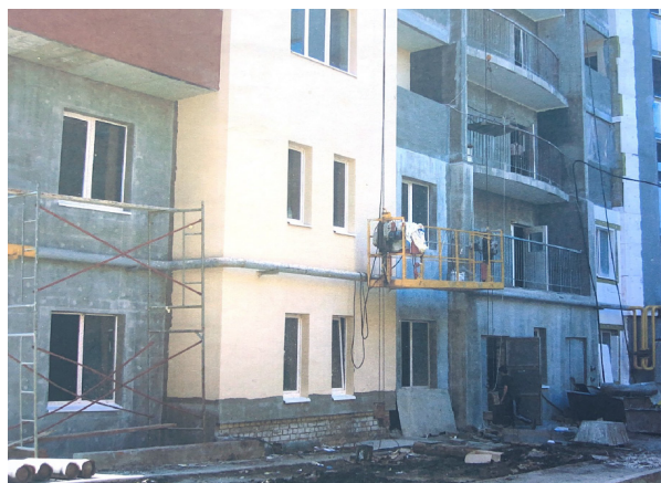
Рис. 3. Выполнение работ по технологии «мокрый фасад» на строительном объекте
