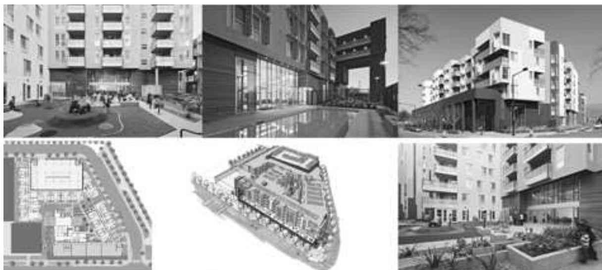
Рис. 3. Жилой комплекс «Station Center Family Housing» в Калифорнии (США)
