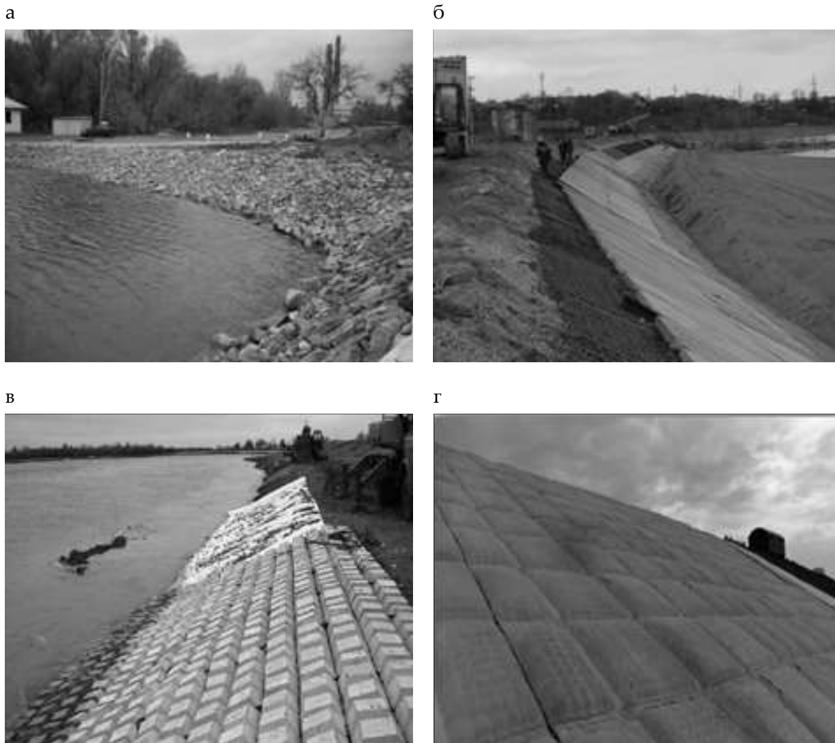
Рис. 1. Технические решения креплений береговых подтопляемых откосов:
