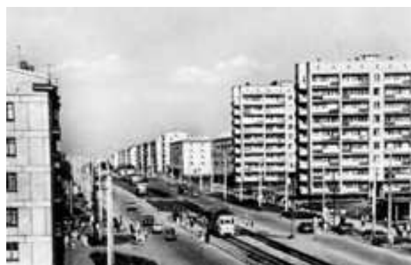
Рис. 2. Застройка ул. Ю. Гагарина с включением девятиэтажных зданий
