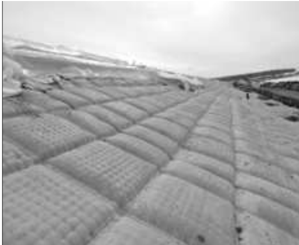
Рис. 2. Примеры использования бетононаполняемых текстильных матов в Самарской области: а – Михайло-Овсянский гидроузел; б – мостовой переход «Кировский»
