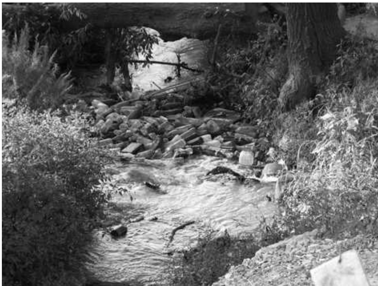
Рис. 4. Фотография существующего выпуска дождевой канализации в Постниковом овраге
