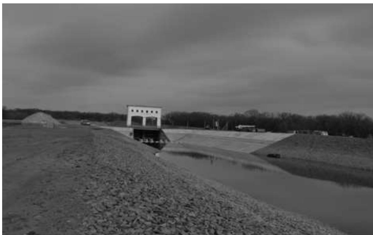
Рис. 4. Участок Донского магистрального канала после проведения реконструкции (дата проведения обследований – 08.04.2014 г.)
