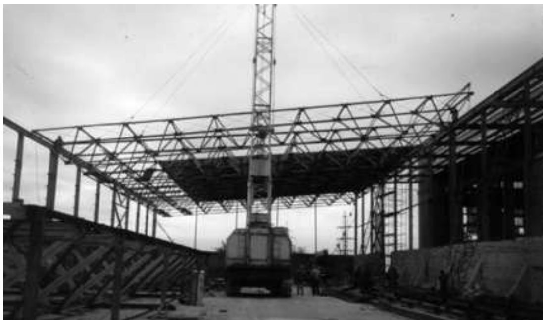
Рис. 3. Монтаж пространственной конструкции покрытия
