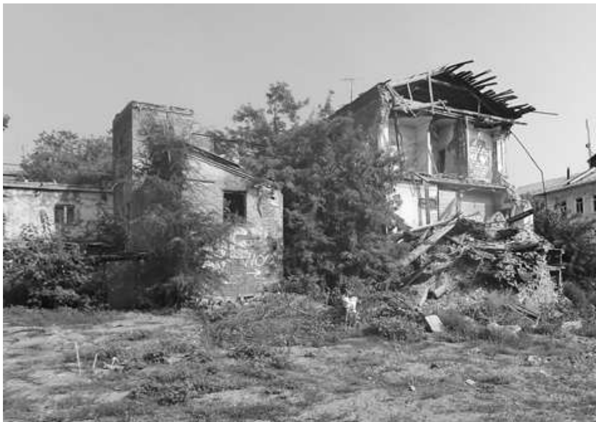
Рис. 1. Часть дома, подлежащая демонтажу. Вид по ул. Максима Горького
