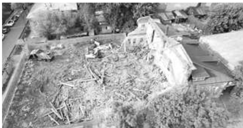
Рис.6. Разборка на завершающем этапе
