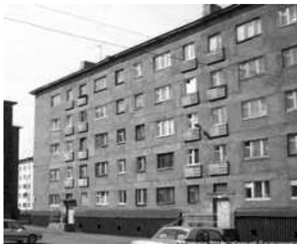
Рис. 3. Панельный дом в Норильске с продуктами в подвальном помещении [20]
