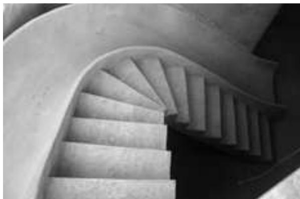
Рис. 1. Лестница монолитного железобетона
