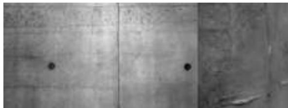
Рис. 3. Стык опалубочных форм, технологические отверстия. Наплывы бетона
