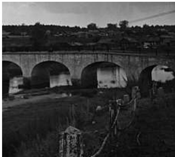
Рис. 3. Ограждение моста в селе Багаряк
