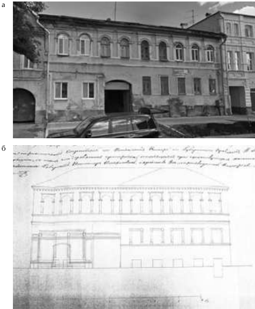
Рис. 8. Жилой дом (ул. М. Горького, 85): а – фото 2014 г.; б – архивный чертеж фасада здания
