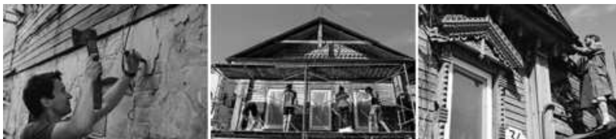
Рис. 6. Ход работ – подготовка фасадов домов по ул. Льва Толстого, 34, г. Самара, 2015 г.
