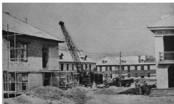
Рис. 11. Строительство новых домов в поселке ЗиС, 1948 г. [29]
